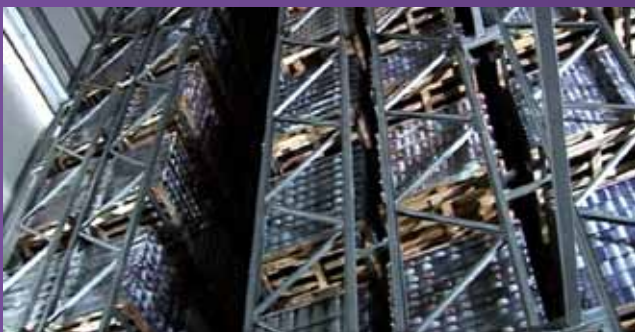
Автоматический накопитель банок (7.000 поддонов)
